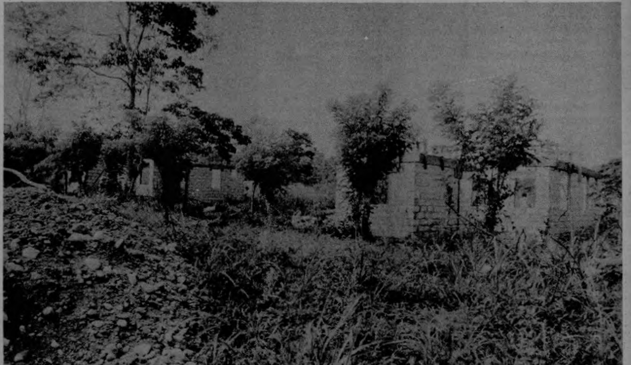
Las luchas del comité de vivienda de Paso Canoas fructifican en la construcción de la nueva urbanización "El Triunfo".
